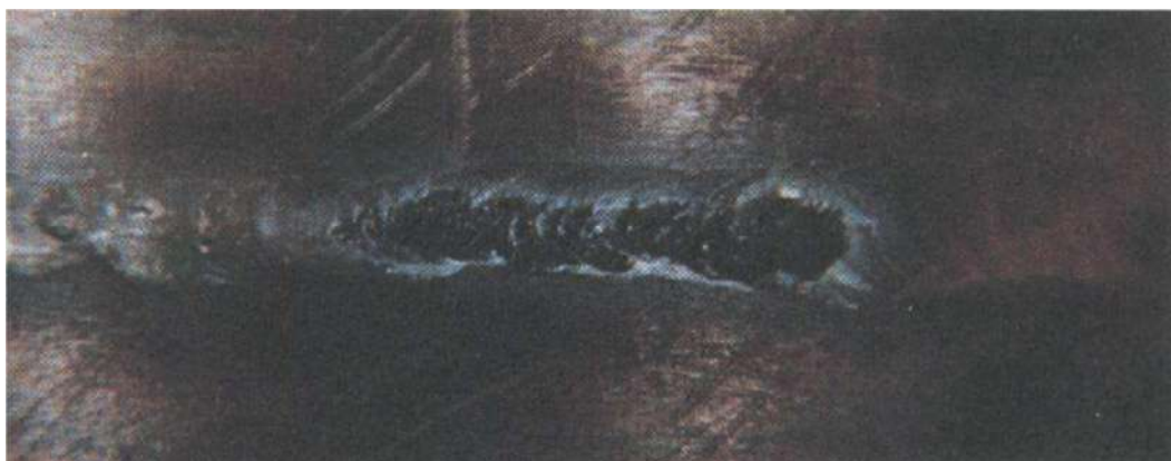
Površinska oksidacija na TIG-om zavarenom nerđajućem čeliku
